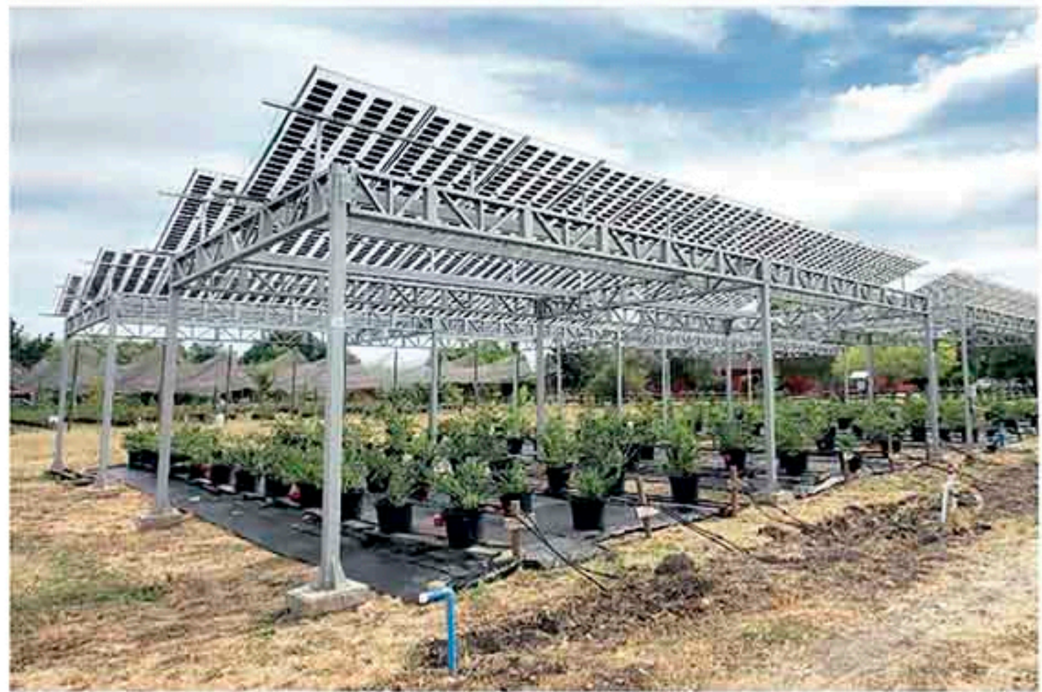
Figura 2. Estructura de granja solar ubicada en el Centro Regional INIA Raihuén.
